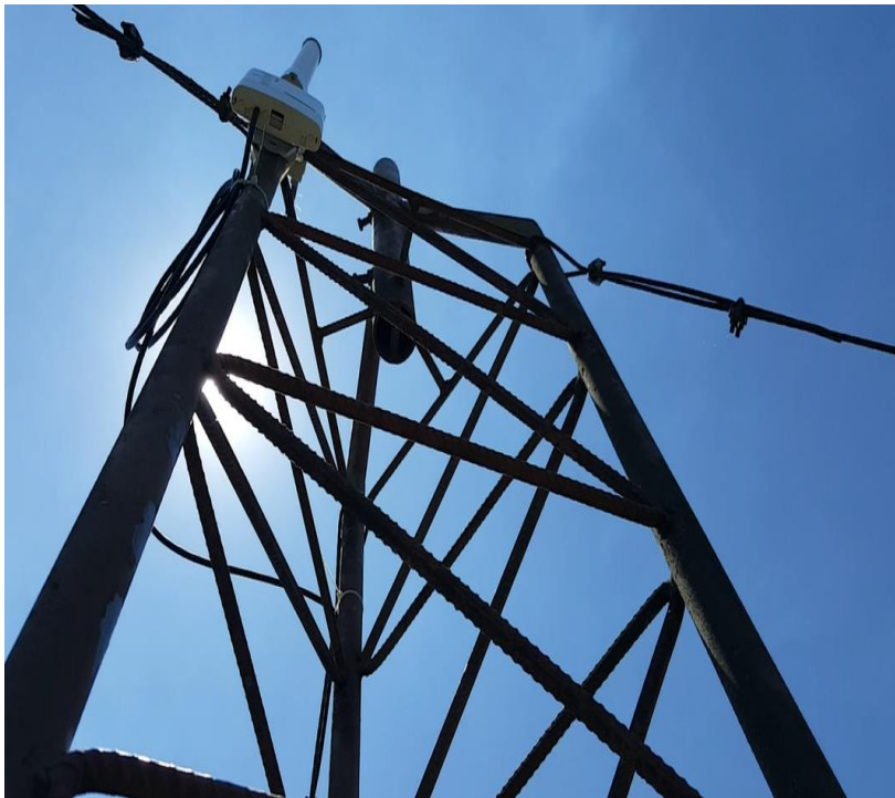
Figura 62: Colocación de los Access point
