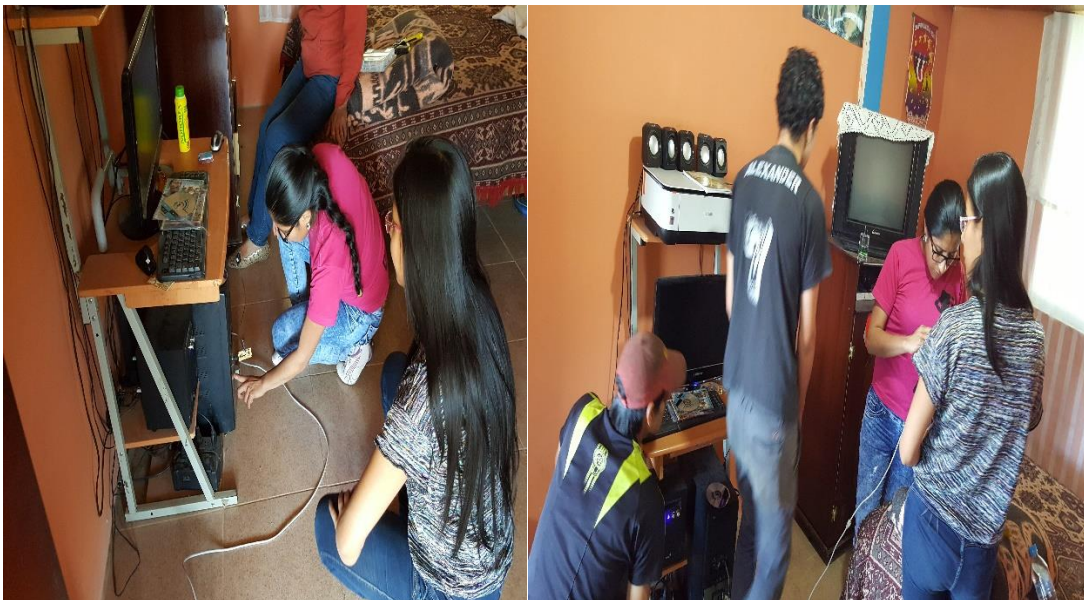
Figura 64: Instalación del servicio en los domicilios
