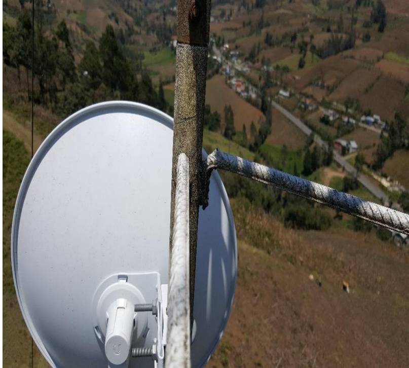
Figura 61: Instalación de las antenas PowerBeam PBE-M5-400.
