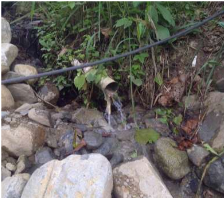
Gráfico 3. Tubería donde desemboca el efluente de la empresa
