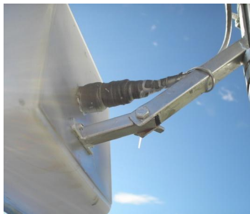
Fig. 2.74 Brazo metálico remachado a la caja plástica
