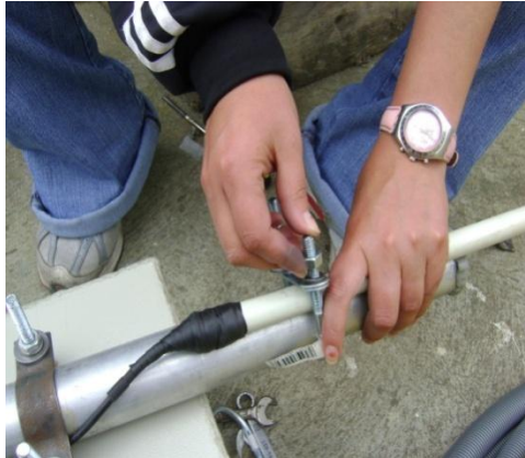
Fig. 2.102 Fijación de la antena Omnidireccional
