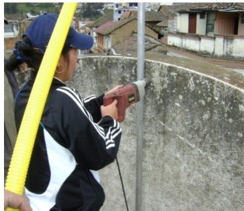
Fig. 2.129 Perforación para la abrazadera metálica Fuente: Creación propia
