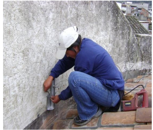
Fig. 2.128 Colocación de la bota metálica Fuente: Creación propia
