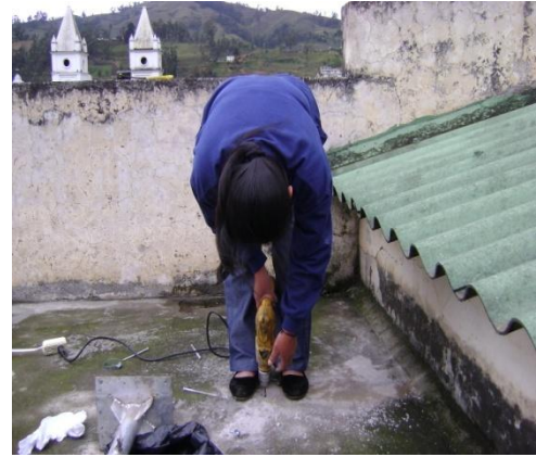
Fig. 2.105 Perforación del concreto Fuente: Creación propia
