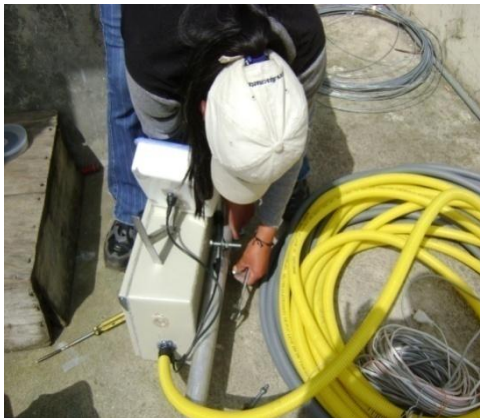
Fig. 2.101 Acondicionamiento de la caja hermética
