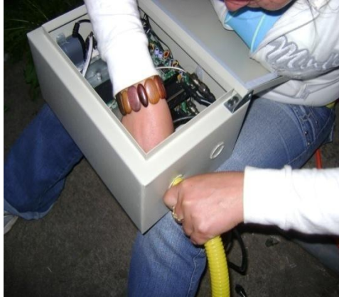
Fig. 2.81 Introducción de la manguera espiral en la gaveta metálica
