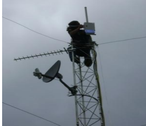
Fig. 2.85 Atornillación de la caja hermética Fuente: Creación propia
