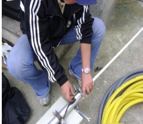
Fig. 2.125 Sujetación de la antena omnidireccional
