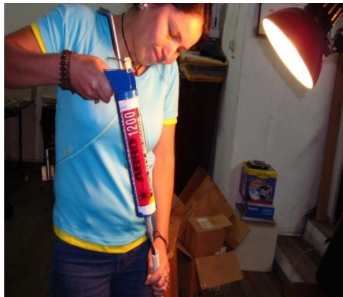
Fig. 2.60 Colocar silicón epóxica Fuente: Creación propia
