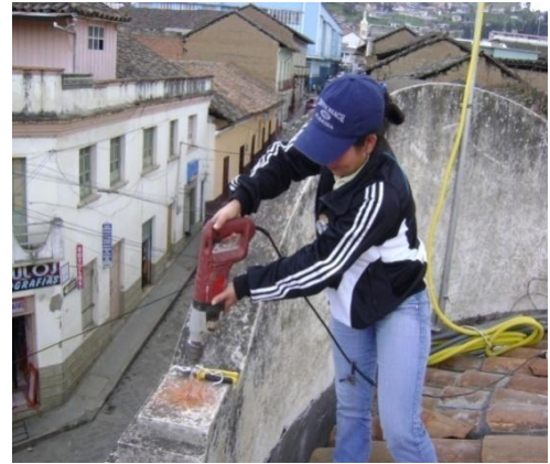
Fig. 2.130 Perforación de la pared Fuente: Creación propia
