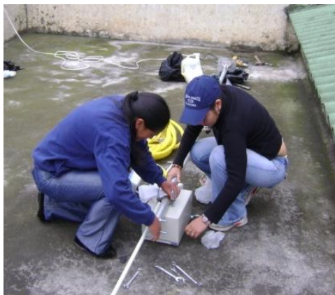
Fig. 2.124 Acondicionamiento del Equipo
