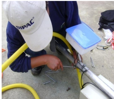
Fig. 2.126 Sujetación de la antena direccional
