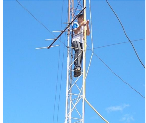
Fig.2.86 Sujetación de la manguera espiral Fuente: Creación propia
