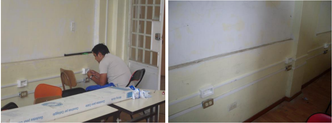
(Fig.44-45) Instalación de Cajetines
