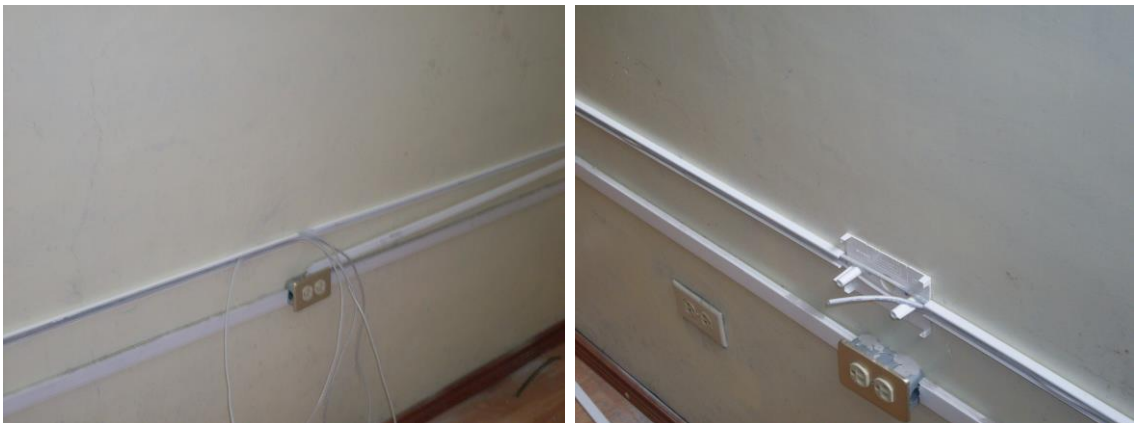
(Fig.44-45) Pasar el Cable RJ45
