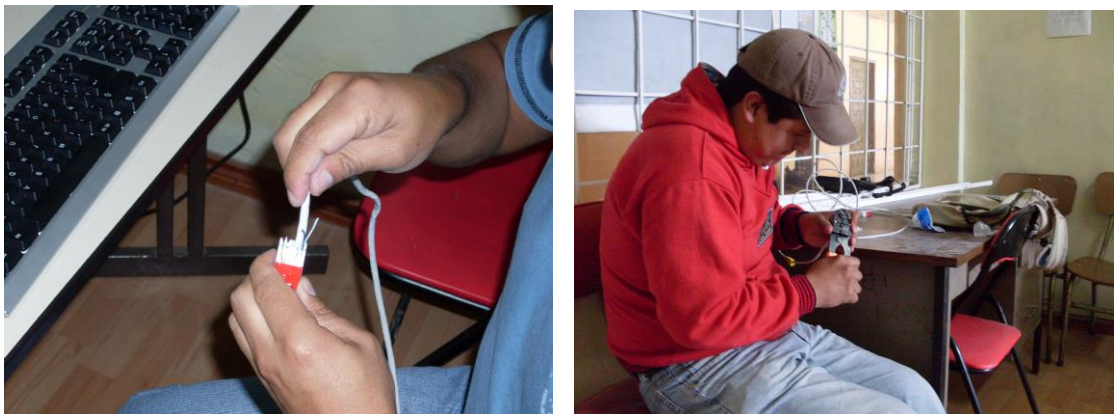
Ponchando los Jack y los RJ45
