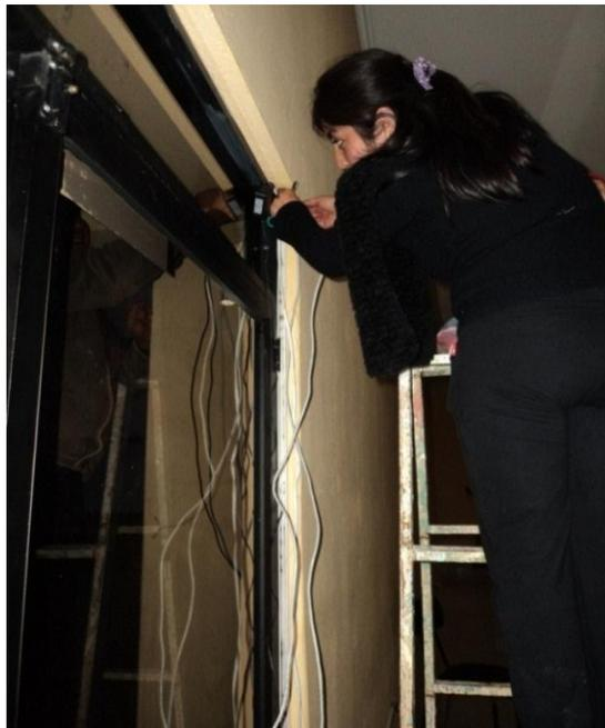
Fig. 2.64 Cable UTP y eléctrico en el borde superior de la puerta del salón principal
