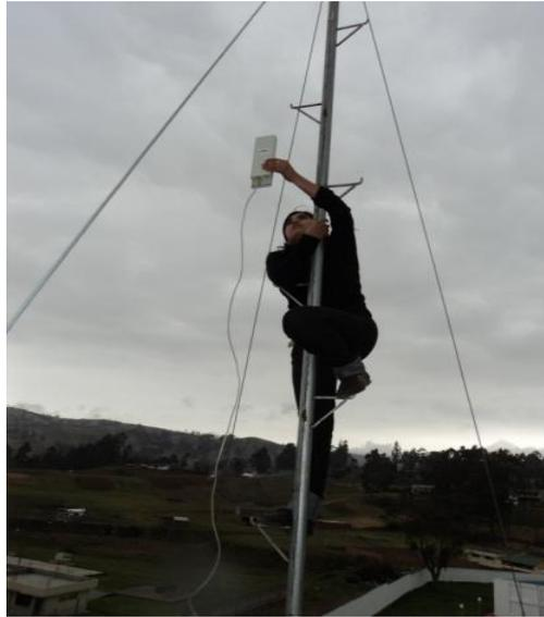
Fig 2.49 Colocacion del NanoStation5 en el mástil de Los Trigales
