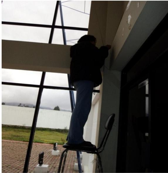
Fig. 2. 63 Introducción del cable UTP al salón principal
