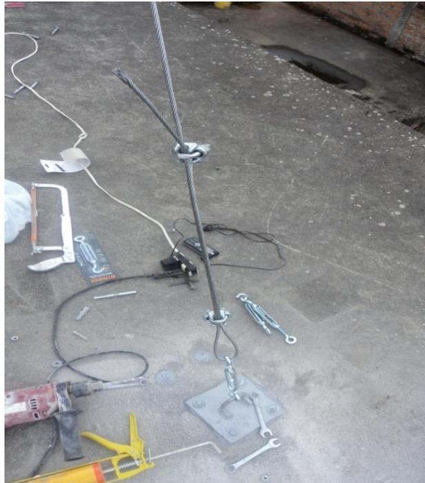
Fig. 2.45 Tensor, cable de acero y candados
