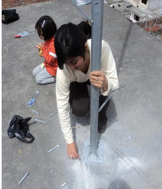
Fig. 2.43 Colocación de pernos de anclaje en la base del mástil
