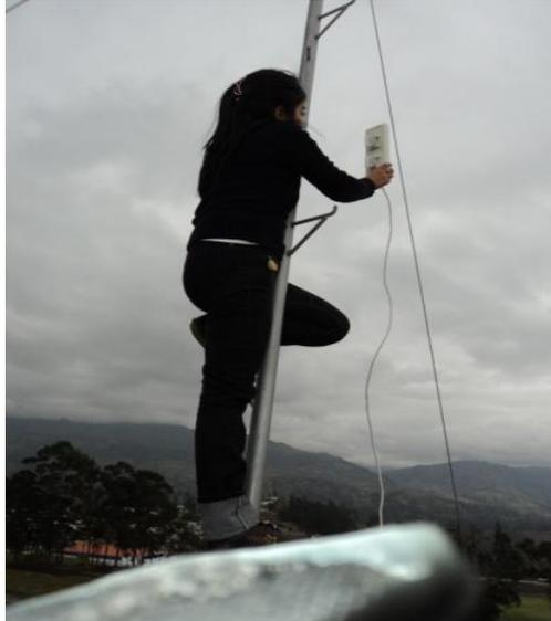
Fig. 2.47 Orientación del NanoStation5 en el mástil de Los Trigales
