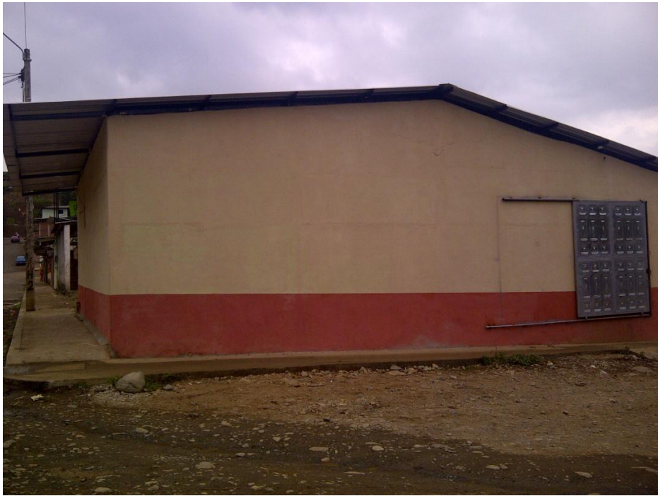
Vista lateral de la estructura actual del Camal Municipal
