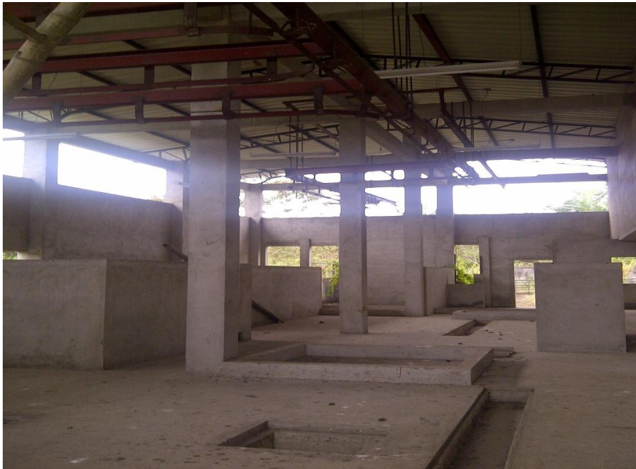
Interior de la nueva estructura del camal municipal habitado por palomas
