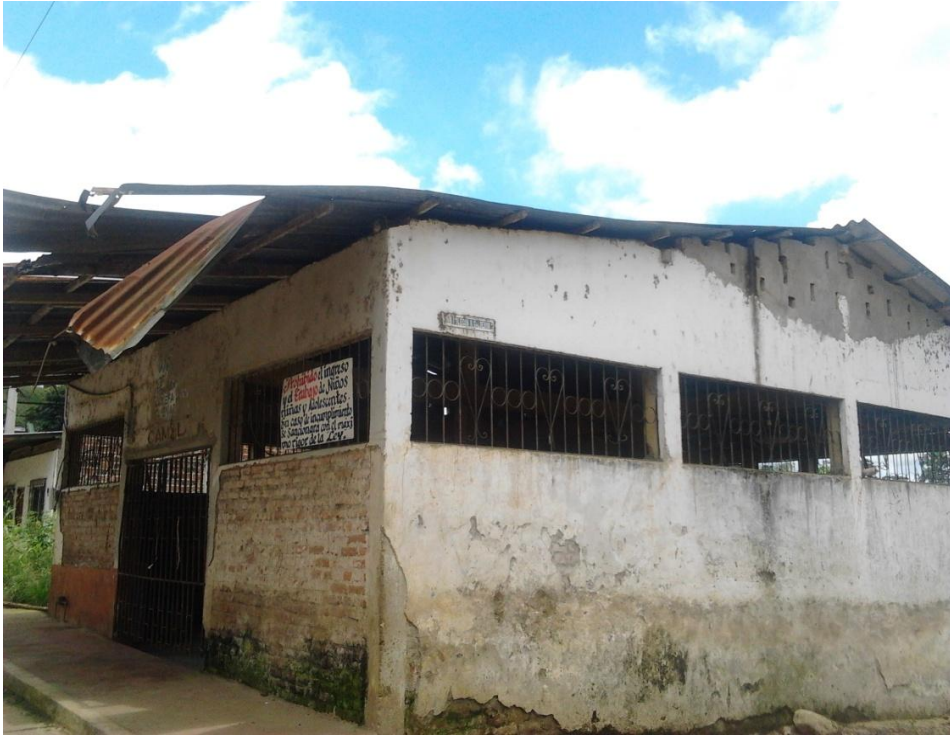
Vista lateral del camal municipal
