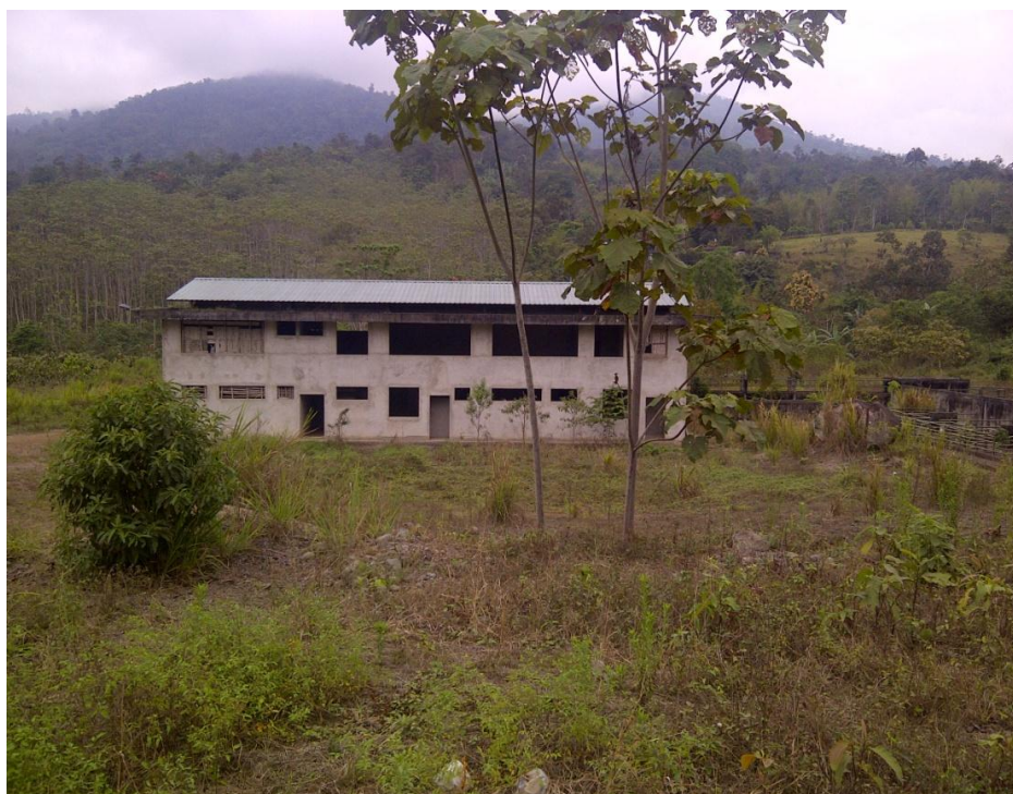
Estructura física del nuevo camal en desuso
