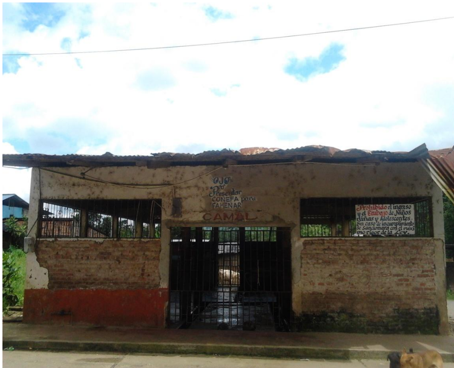
Vista de frente de la Estructura física del camal municipal al iniciar nuestro trabajo
