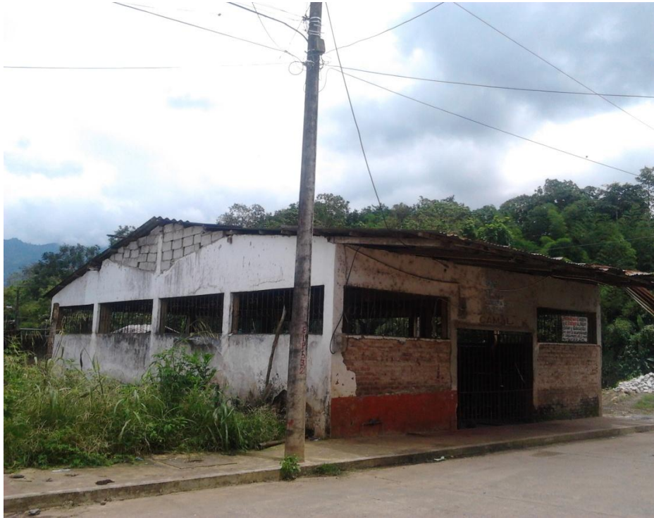
Vista lateral de la estructura física al iniciar nuestra investigación
