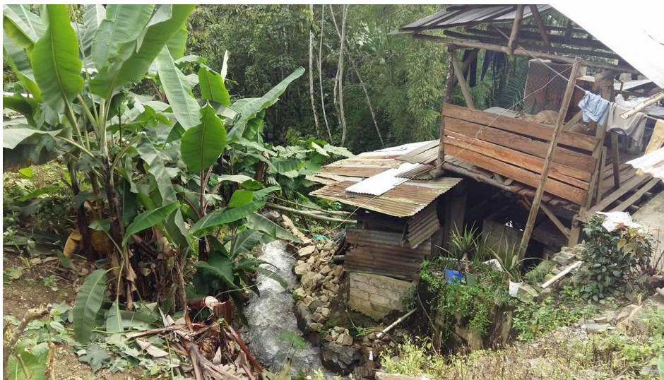
Viviendas ubicadas cerca de riachuelos o alcantarillas
