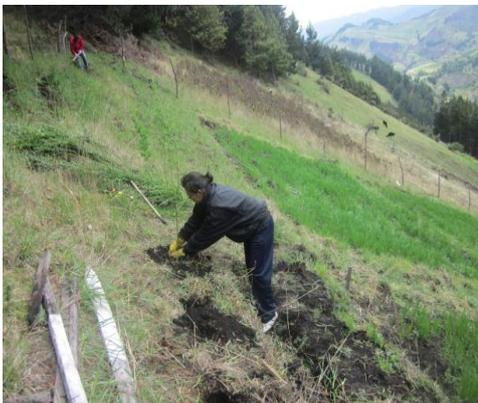
**Foto N° 6.** Realización de Zanjas de desviación del agua
