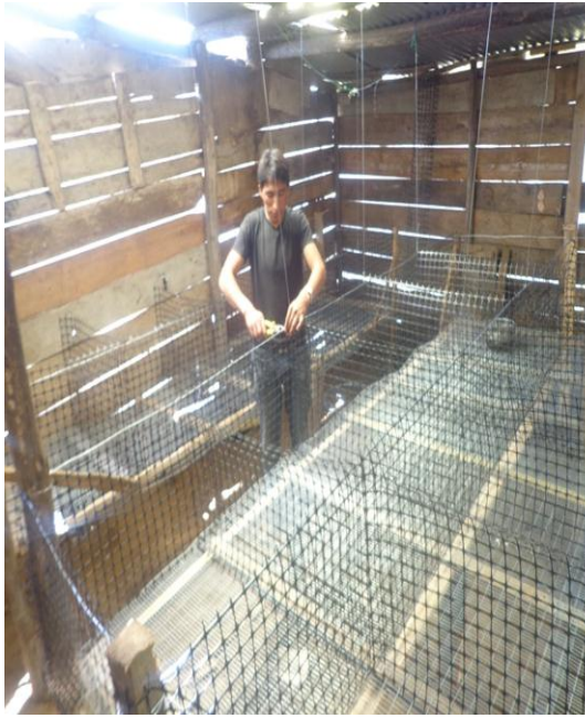
Adecuación de las jaulas.
