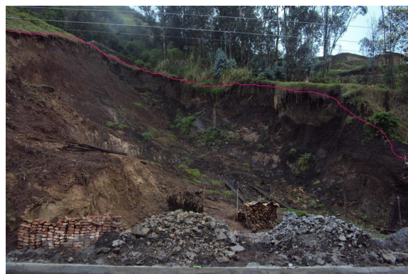
Foto 7.- Ejemplos de cicatrices de deslizamientos menores en la mitad sur de la zona de estudio, terminando con un gran deslizamiento al pie de la zona de estudio.
