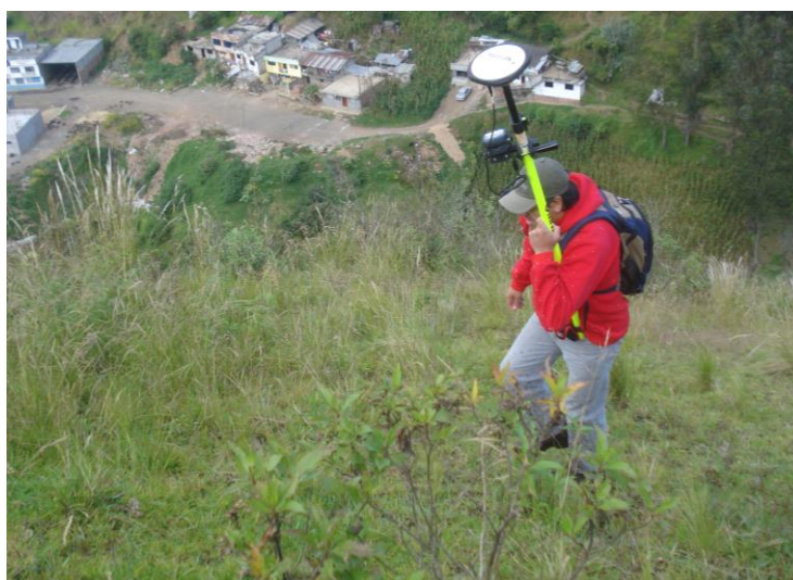
Foto 1. Levantamiento topográfico en el sector de la Sub Jefatura de Transito
