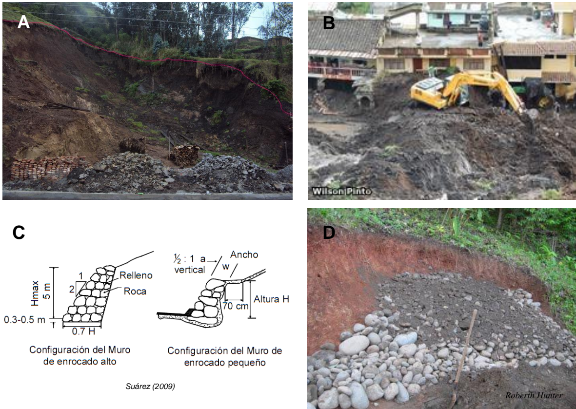
Foto 12.- A: Estado actual de la cicatriz del deslizamiento. B: Masa deslizada poco después del desastre. C: Posible técnica de remediación mediante muro de rocas. D: Ejemplo de deslizamiento estabilizado con esta técnica.
