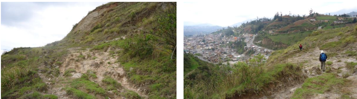
Foto 9.- Imágenes de erosión hídrica en la parte baja de la zona de estudio.
