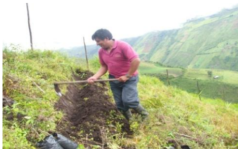
Construcción de zanjas de desviación
